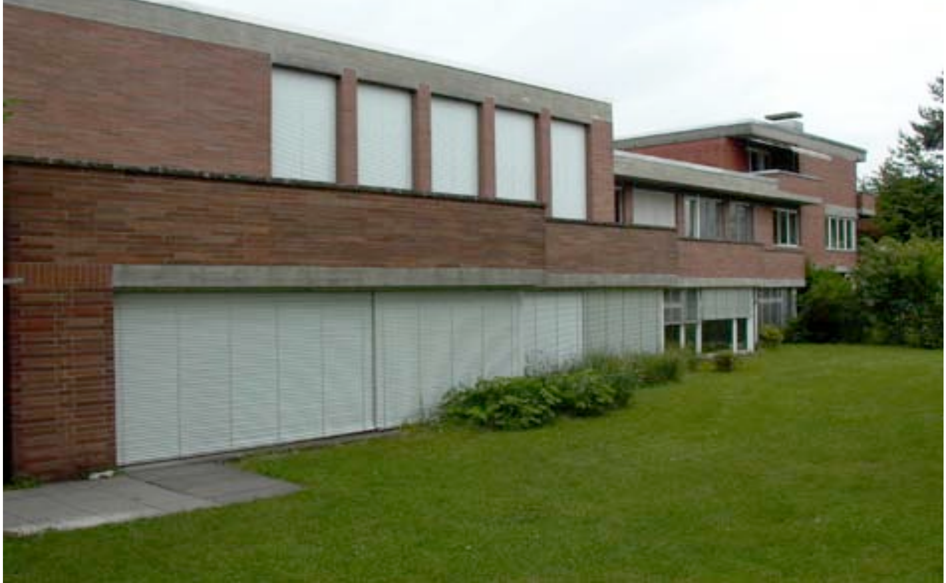
Kirchgemeindehaus und Pfarrhaus Melchenbühl Vor der Sanierung
