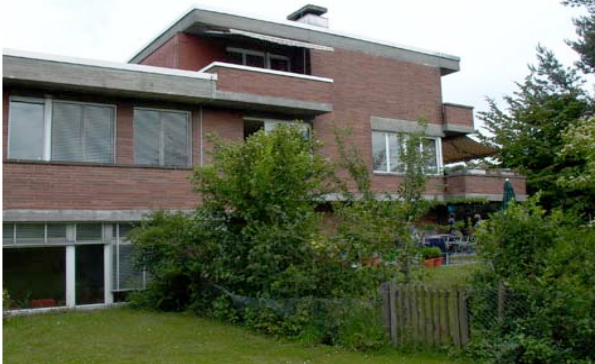
Kirchgemeindehaus und Pfarrhaus Melchenbühl Vor der Sanierung
